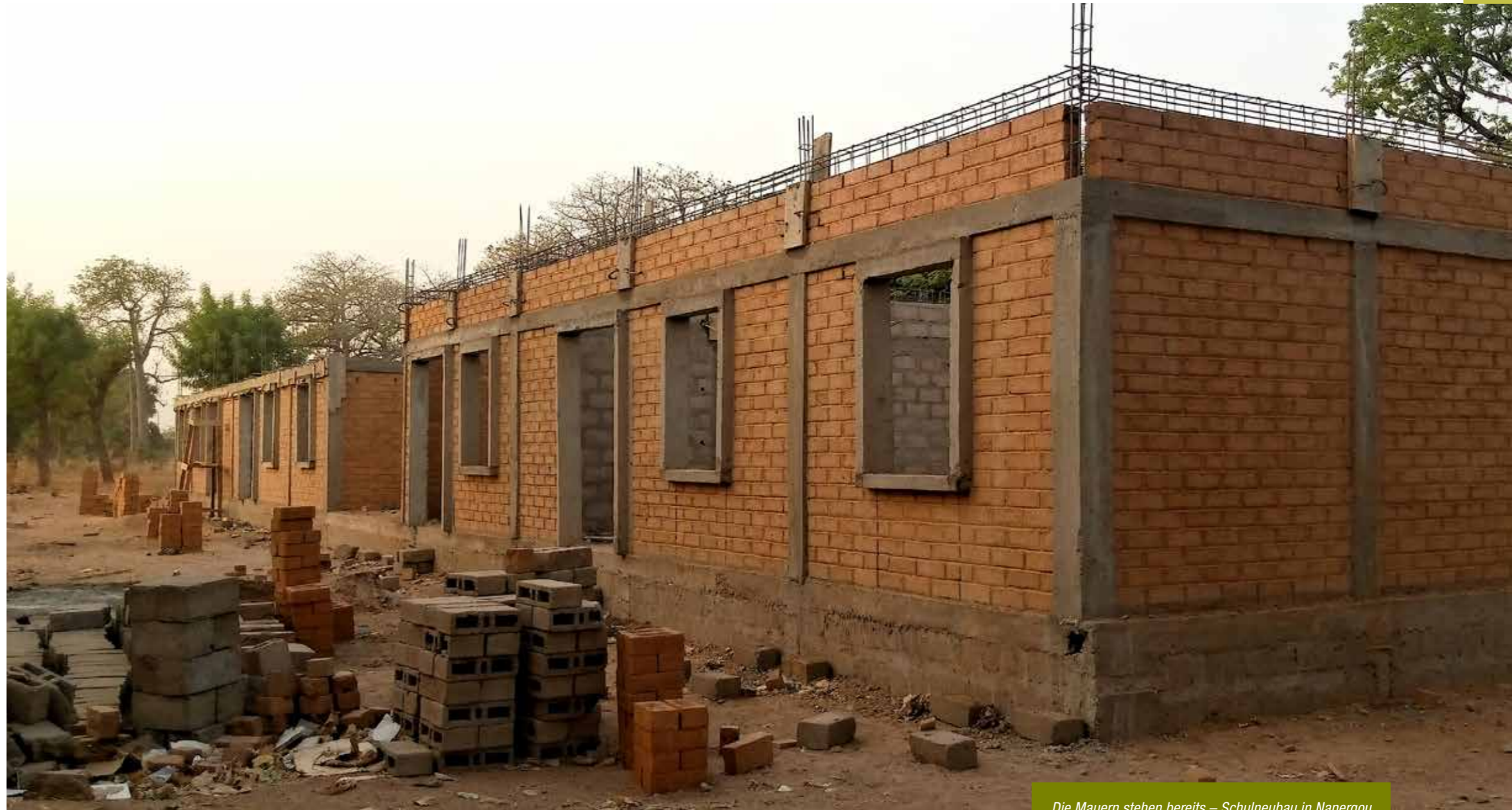
Die Mauern stehen bereits – Schulneubau in Nanergou
