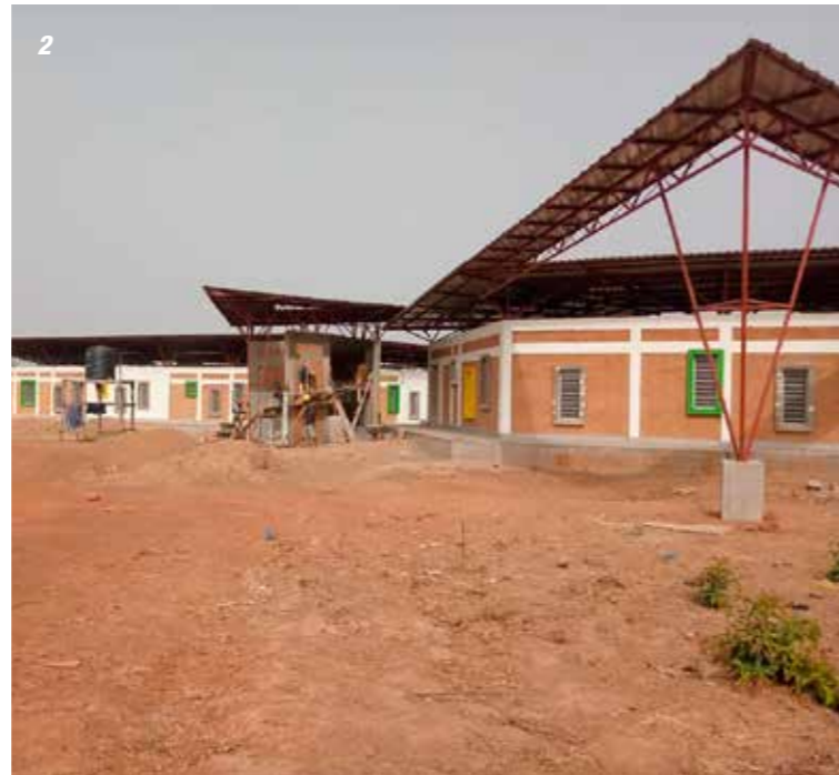
1 Die Ankunft der fünf Container im Krankenhaus 2 Das Krankenhaus kurz vor seiner baulichen Fertigstellung
